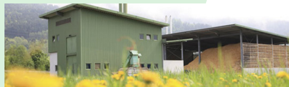
Фигура 3: Квартална топлоцентрала в Австрия. Складът за дървесен чипс е разположен в дясно, котелното помещение в ляво.
